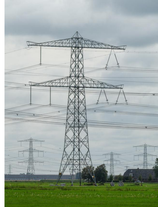
Verhoging ondergeleider en dichterbij elkaar brengen via verlengde ketting
