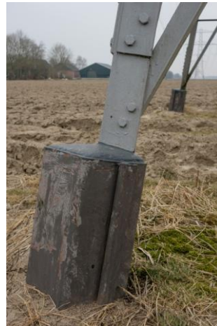
Typische fundatie met kokerpalen (damwandplanken)
